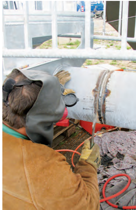
Die Tragkonstruktion wird vor Ort verschweißt...
