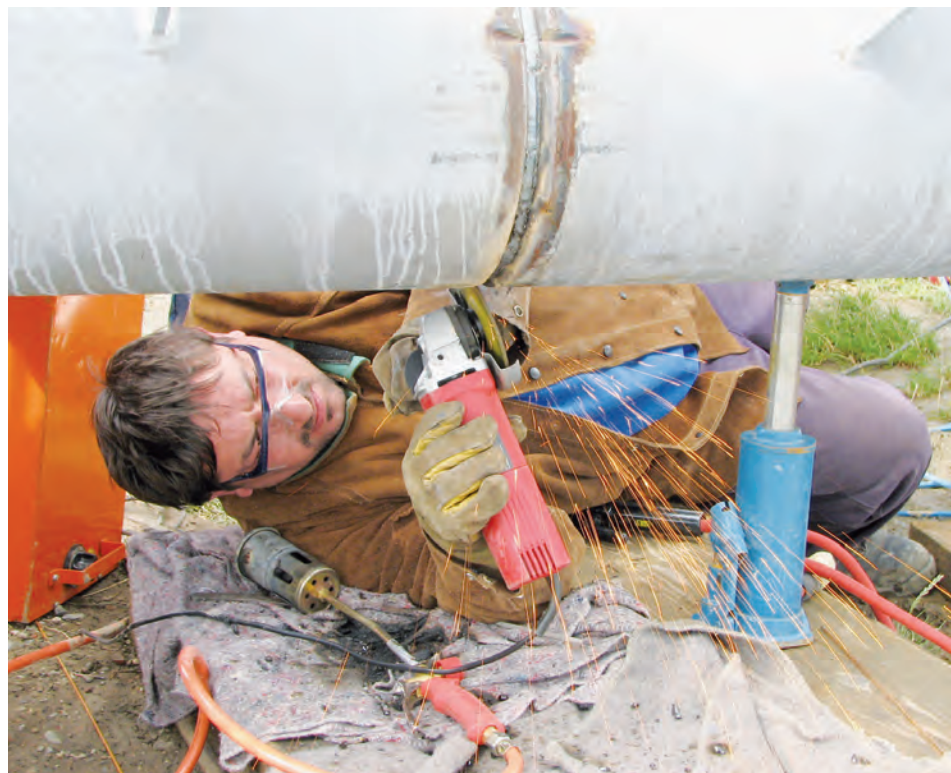
Die Tragkonstruktion wird vor Ort verschweißt...
