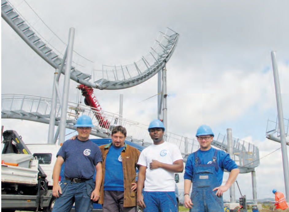
Stolz auf geleistete Arbeit: Monteure der Firma Gründken
